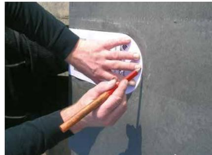
Die mitgelieferte Schablone an der Unterseite der Fassadentafel anlegen und Ausschnitt anzeichnen.
