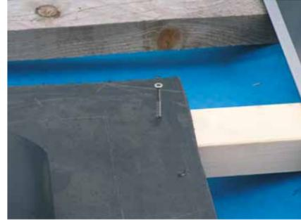
Befestigung der Grundplatte mit 2 Senkkopfschrauben.
