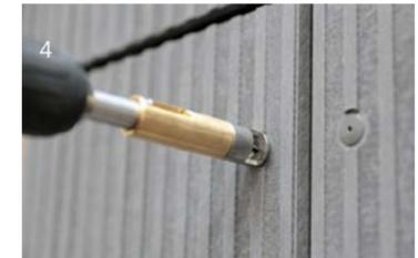
Fassadentafel an Alu-Uk anhalten (auf Richtscheid abstellen) und Alu-Uk vorbohren. Hierzu die Bohrlehre verwenden (erhältlich inkl. Bohrer).
