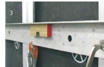
Es wird der Einbau der Fassadentafeln von oben nach unten empfohlen. Hierzu wird die vorbereitete Fassadentafel auf das Richtscheid gestellt und die exakte Fuge mittels Distanzhalter hergestellt.
