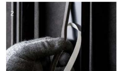
Vor dem Aufbringen der Fassadentafel muss der Schaumstoffstreifen 6x9 auf die Alu-Uk geklebt werden. Der Schaumstoffstreifen gewährleistet eine dauerhafte Lage-sicherung der Fassadentafel.
