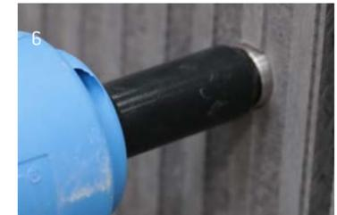
Universal-Niet setzen. Darauf achten, dass der Nietkopf plan anliegt. Es kann die Nietsetzlehre verwendet werden.
