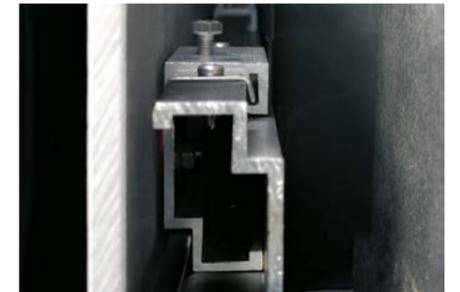
Fertig eingehängte Fassadentafel auf Alu-Uk.
